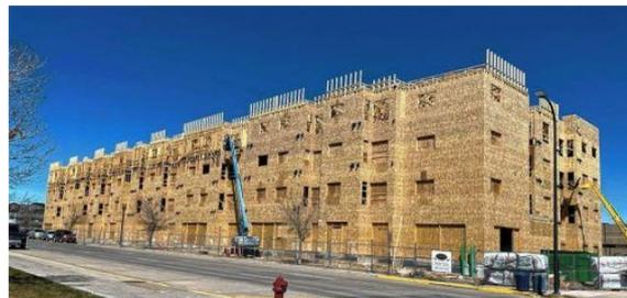
**Die komplette Fassade** des Gebäudes ist aus Holz. Nur die Tiefgarage ist aus Beton. FOTO FRITZ
